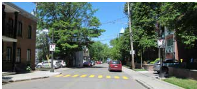
Figure 20 – Saillie et passage piéton non contrôlé aménagés entre deux intersections
